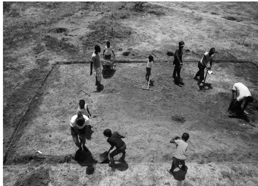
POSTAVITEV TEMELJEV ZA ODER, PROJEKT SOWETO, 2014. FOTOGRAFIJA RADOŠ VUJAKLIJA.
